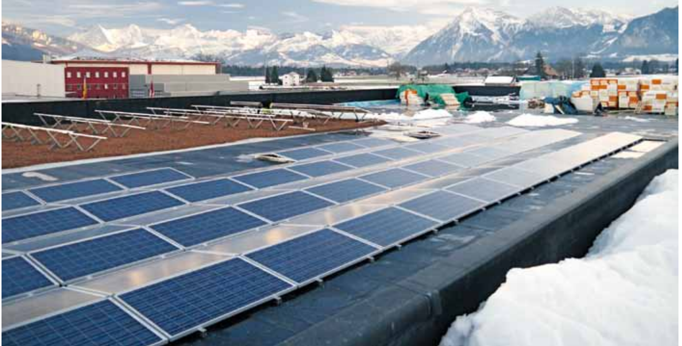
Structure d'un EnergieGrünDachs des entreprises Contec/Crescendo/Coex. Au premier plan, des panneaux plats est/ouest, peu végétalisables; au centre, des panneaux montés sur châssis sud – idéal pour une végétalisation différenciée et riche en espèces.
