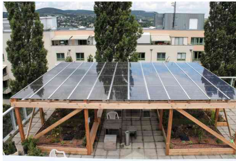
Solarpavillon auf dem Dach: halbdurchsichtige PV-Module als Regenschutz, Pflanzen für Schönheit und Lebensraum. (Bilder: Irene Zluwa)
