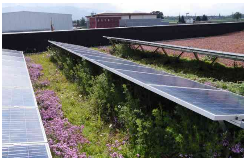
Klassische Kombination: schräg aufgeständerte PV-Module mit Vegetation. (Bild: Fritz Wassmann)
