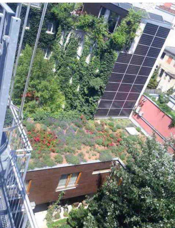
PV-Anlage auf Dach und Fassade plus Fassaden-grün. (Bild: Irene Zluwa)
