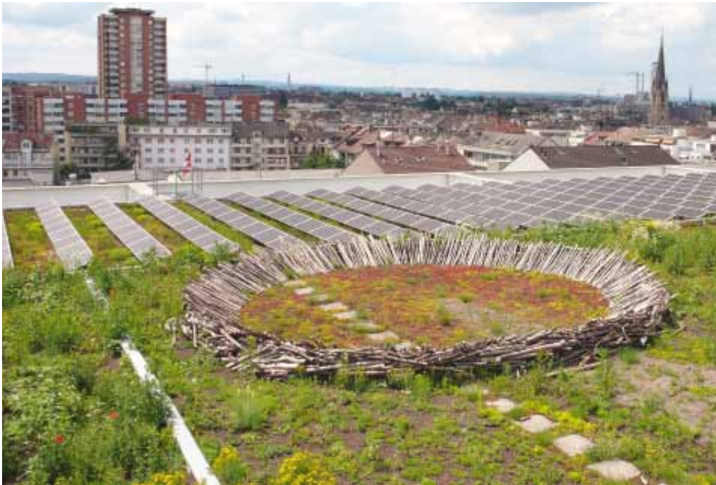
Das fussballfeldgrosse Gründach der Messehalle 1 in Basel dient als ökologische Ausgleichsfläche. Mit den Solarpaneelen werden im Jahr rund 312.000 Kilowattstunden Energie produziert.
