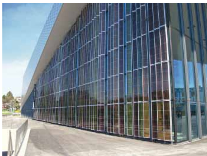
Stimmungsvolle Fassadengestaltung mit der neuesten Generation farbiger und transparenter Solarzellen (Graetz-Zellen) am vor Kurzem eröffneten SwissTechConventionCenter an der EPFL in Lausanne.
