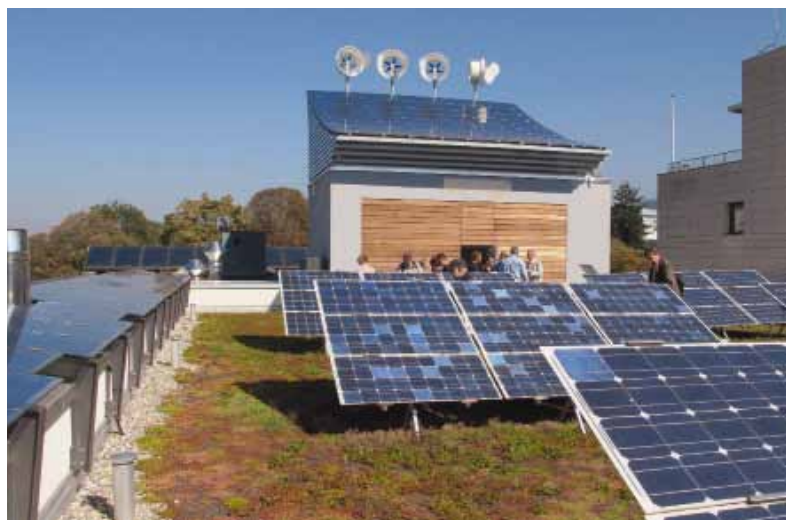
PV, Begrünung und Windenergie ergänzen sich auf dem Dach des Vier-Sterne-Hotels «Victoria» in Freiburg im Breisgau.
