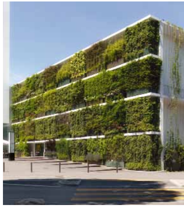
Modulare Fassadenbegrünung in Gefässen am Beispiel des Einkaufszentrums Stüchi in Basel (Planung: Fahrni und Breitenfeld, Basel)
