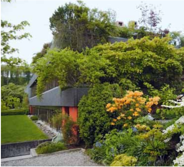
Ein Firmengebäude, mehrstöckig begrünt (Gfeller Elektro in Hinterkappelen BE; Planung: Daniel Moeri/Fritz Wassmann).
