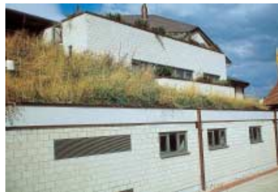
Übermässiges Wachstum: Wegen Brandgefahr sollte hier mindestens einmal jährlich gemäht werden.
