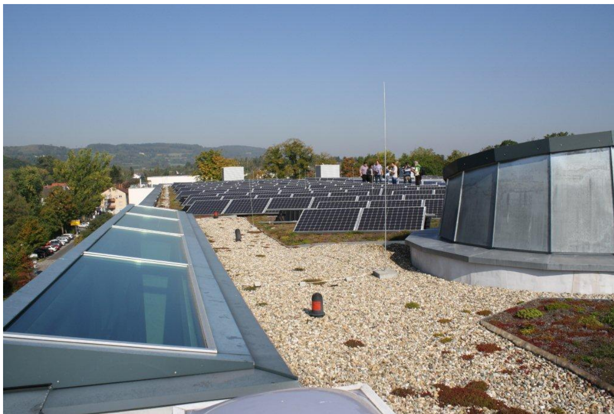
Abb.1: Dach der Stadthalle Singen
