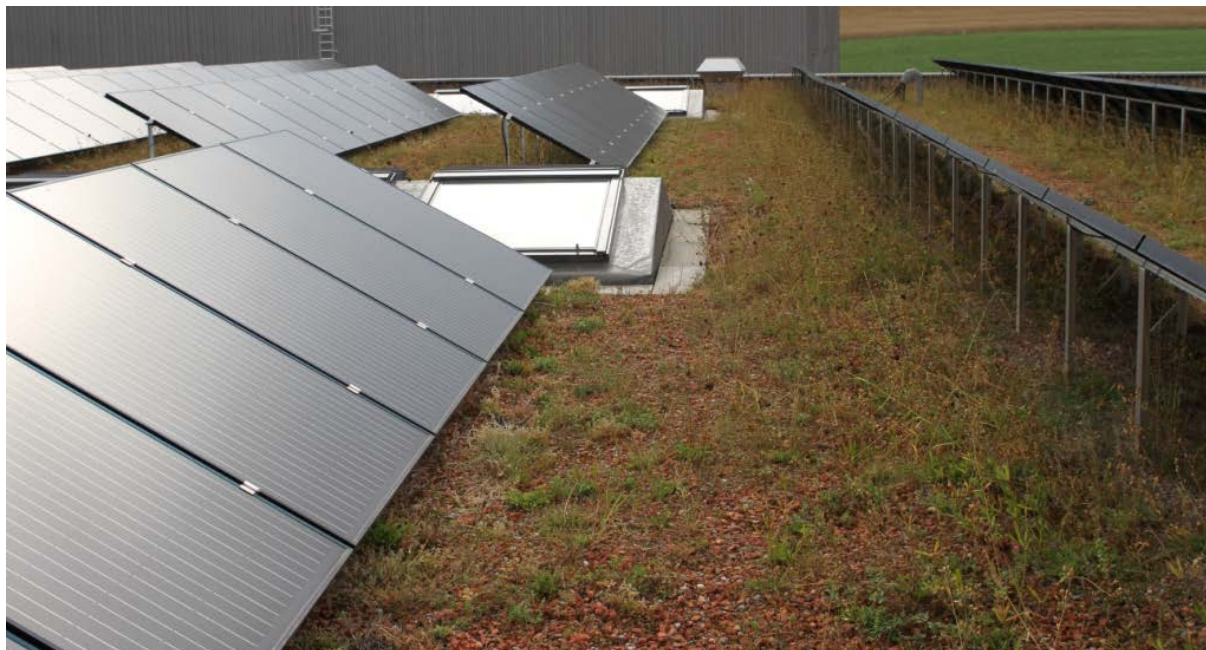
Abb. 3: Die Kombination von Dachbegrünung und Solartechnik ermöglicht eine attraktive und ökologisch wertvolle Nutzung von Dachflächen.
