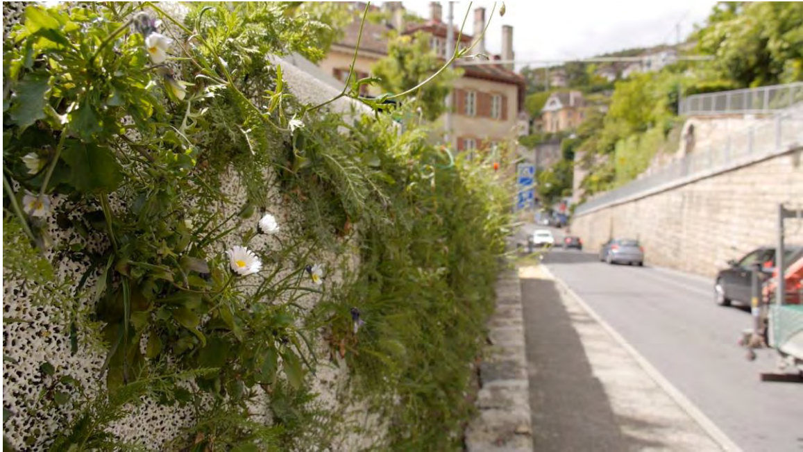
Abb.2: Vertikal-Begrünung mit Skyflor® in Neuenburg.
