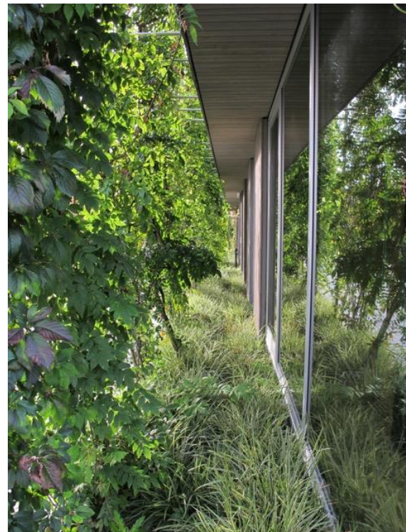
Abb.2: Fassadengrün schafft kühles Mikroklima am Gebäude des Green City Hotel in Vauban (Freiburg im Breisgau); Fritz Wassmann.
