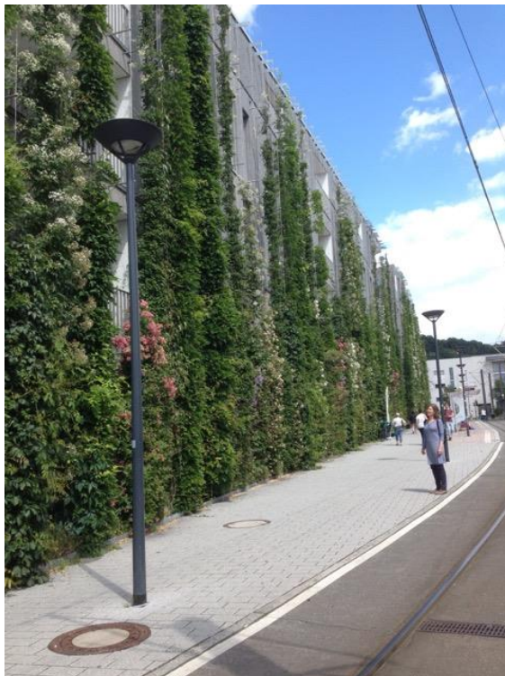
Abb.1: Attraktiv begrünte Fassade am Green City Hotel in Vauban (Freiburg im Breisgau); Hans-Ruedi Amrein-Gerber (SFG).
